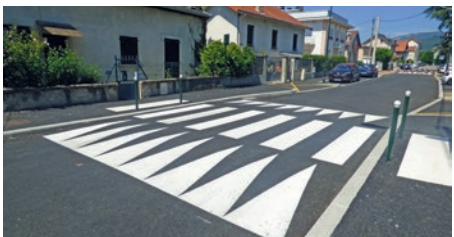
Exemple de passage piétons en plateau
