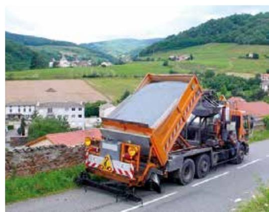
Mise en place de l'émulsion de bitume recouverte de gravillons
